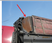
〈측면부 철판 용접〉
