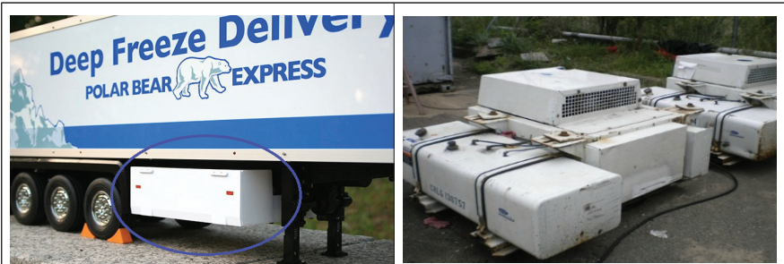
〈냉동컨테이너 발전기 설치〉
